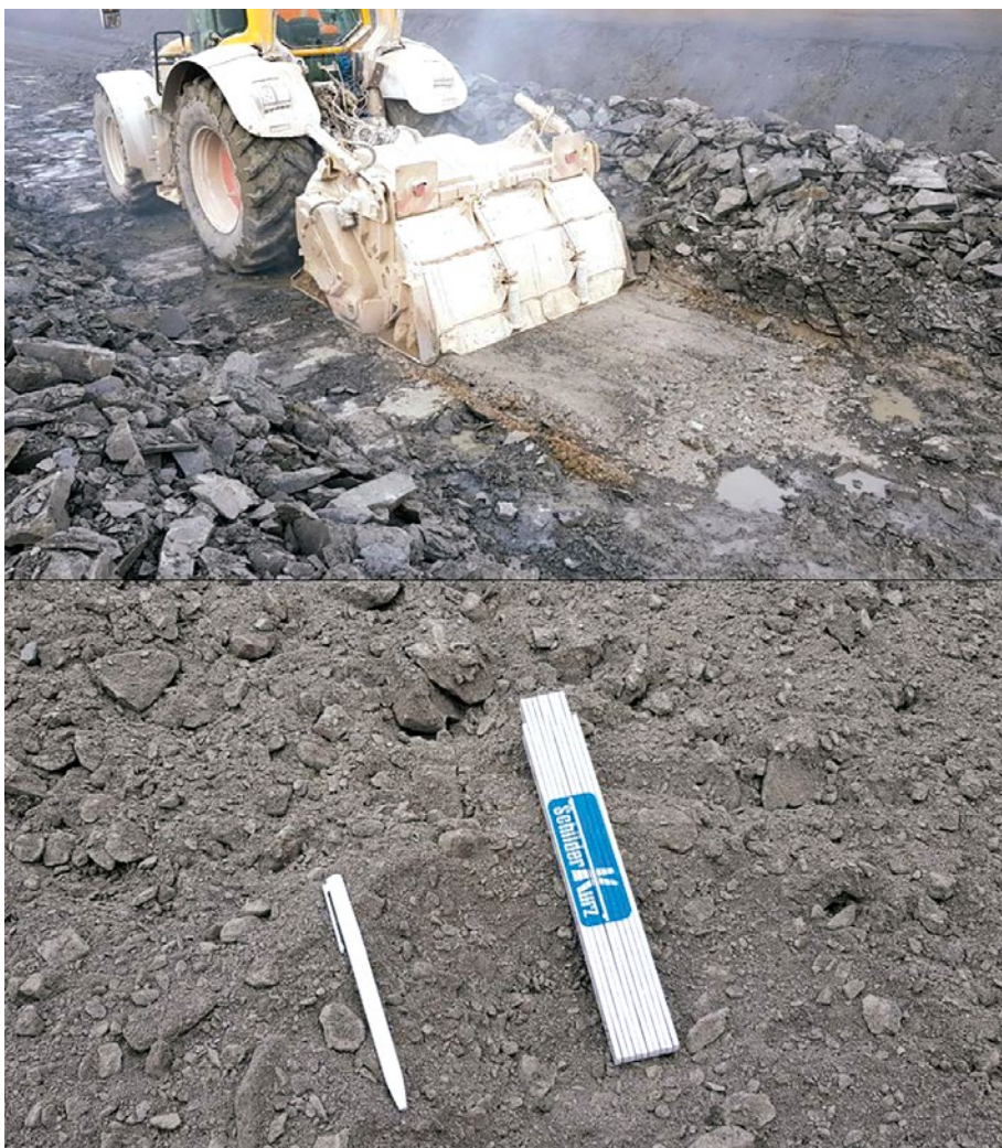
Abb. 6: Einsatz einer Felsbrecherfräse zum Zerkleinern von veränderlich festen Gesteinen
