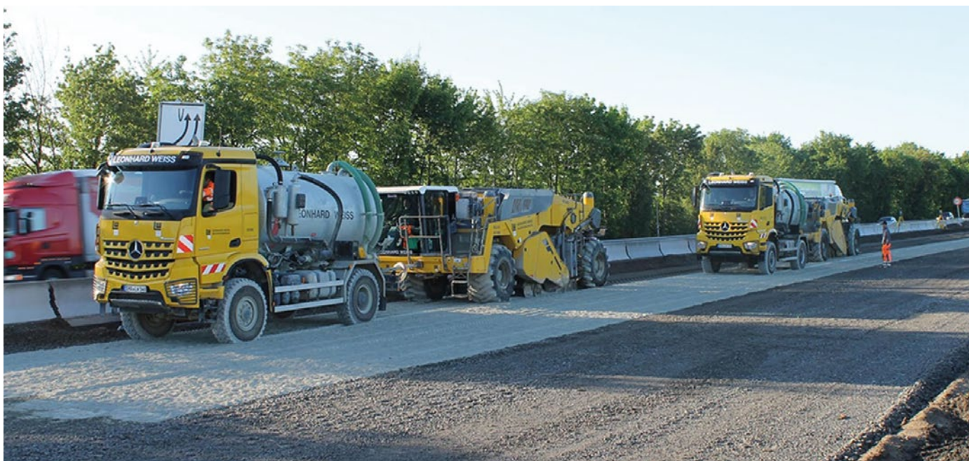
Abb. 7: Bodenfräse mit Wasserwagen
