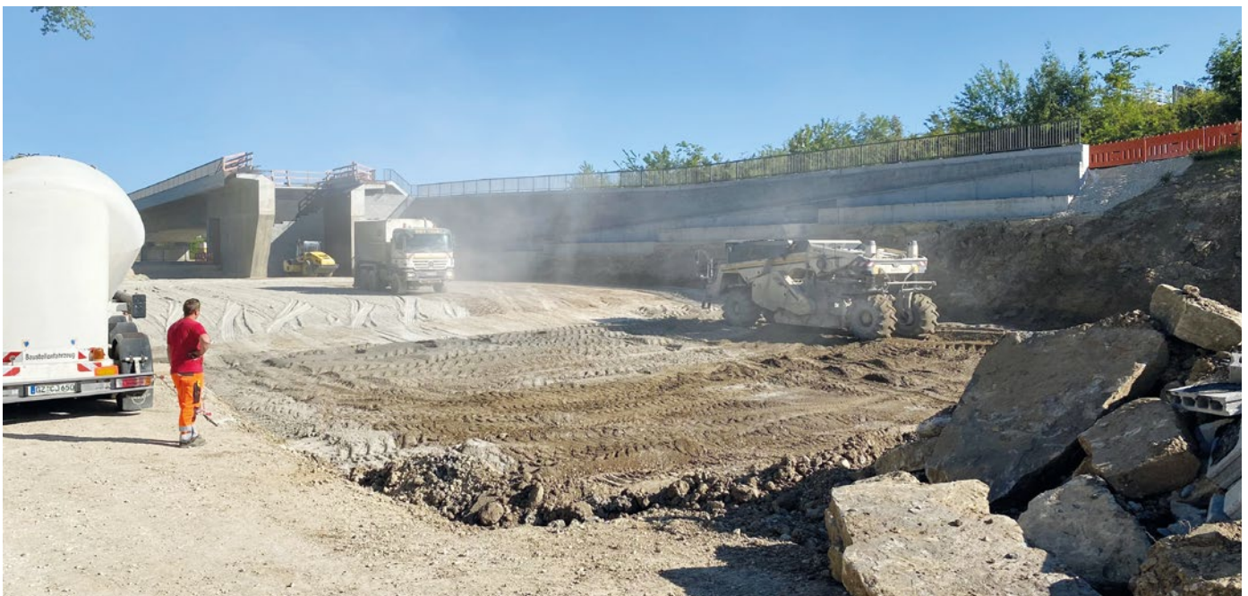
Abb. 4: Durchführung der Qualifizierten Bodenverbesserung im Hinterfüllbereich
