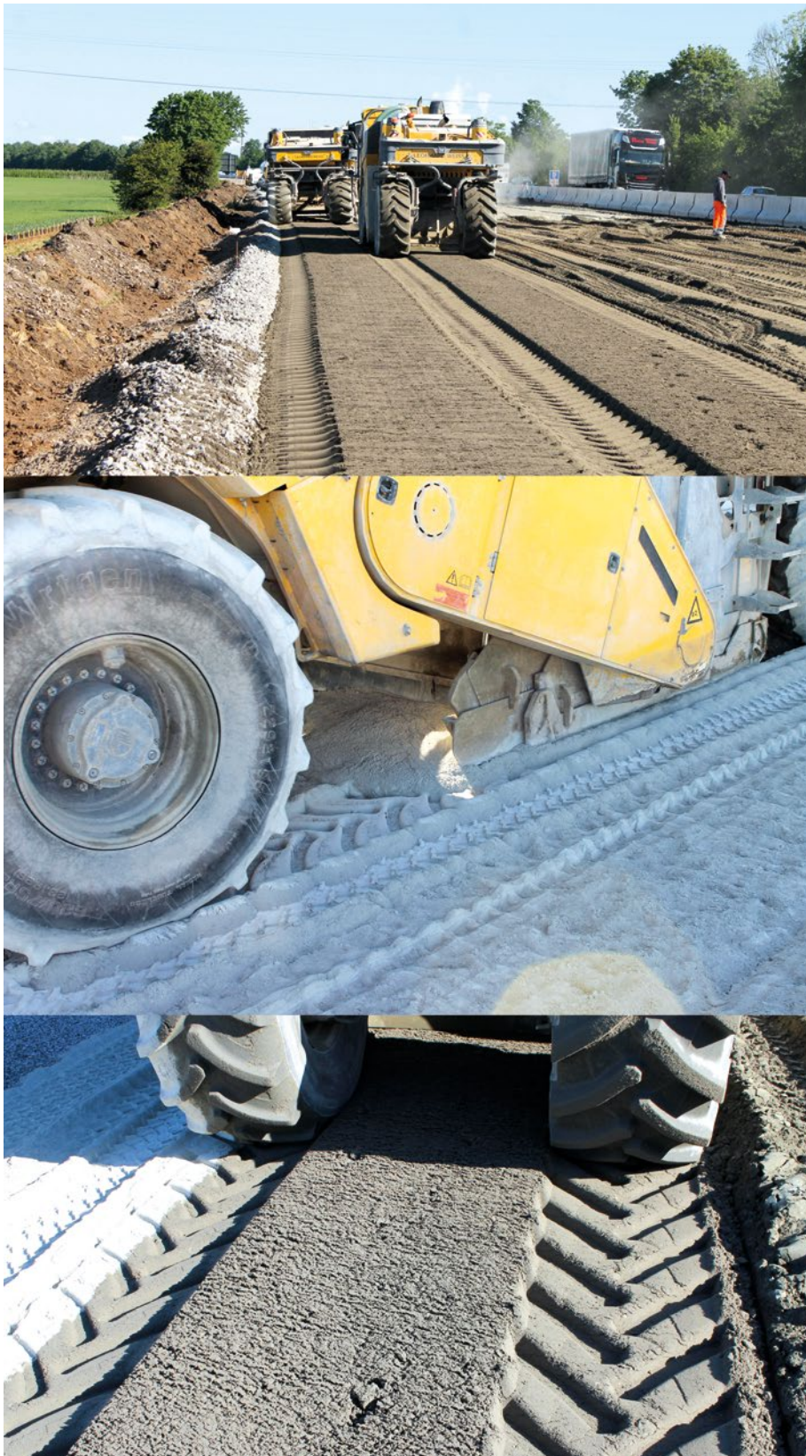
Abb. 2: Einsatz einer Bodenfräse zum Einmischen von Bindemittel
